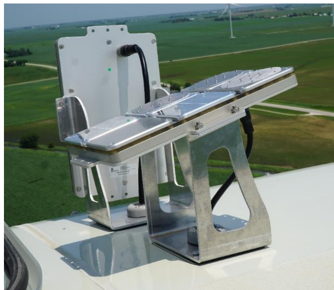
Unités de dissuasion des chauves-souris montées sur la nacelle d'une éolienne.
